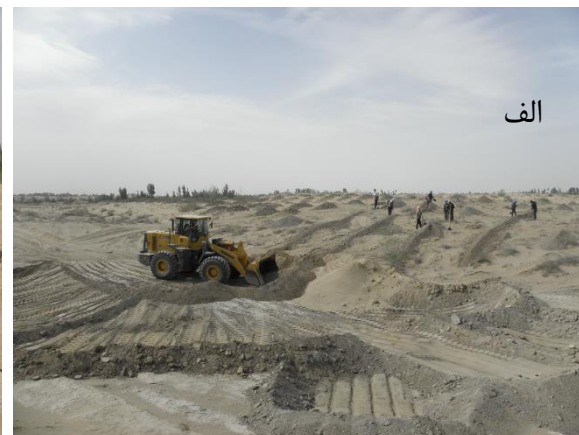
شکل ۱-۵۴- استفاده از ادوات مختلف جهت احداث پشته‌های رسی (الف) ماشین‌آلات و (ب) نیروی کارگری
