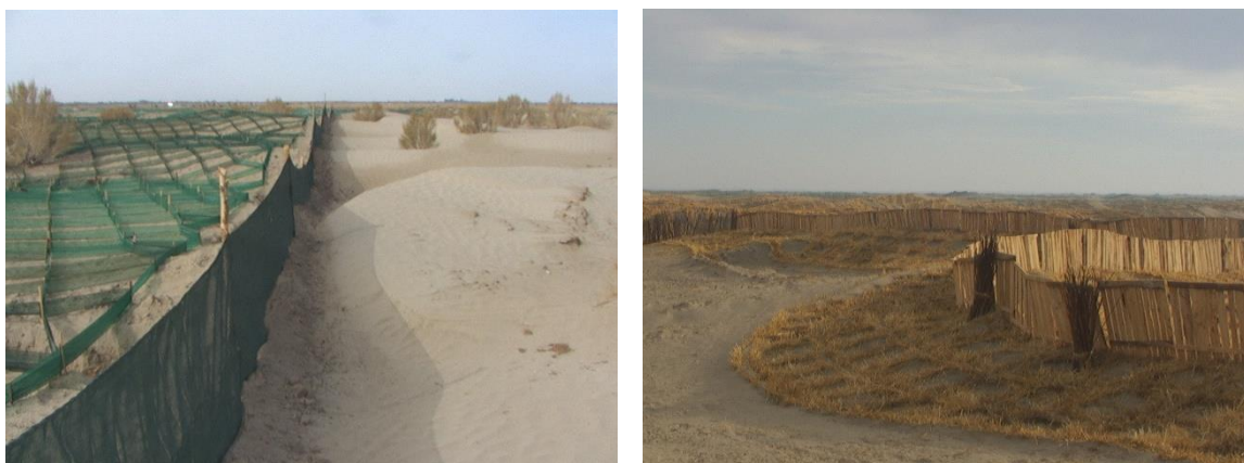
شکل ۱-۶۳- احداث بادشکن کوتاه و بلند در کنار هم به منظور به دام انداختن و تثبیت ذرات خاک
