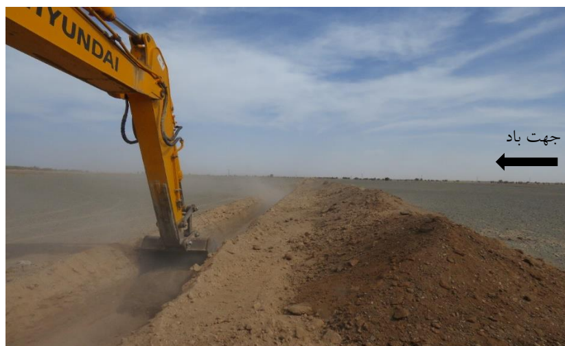
شکل ۳-۴- اجرای تله رسوبگیر توسط بیل مکانیکی
