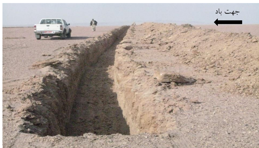
شکل ۳-۵- نمایی از خندق و خاکریز احداث شده
