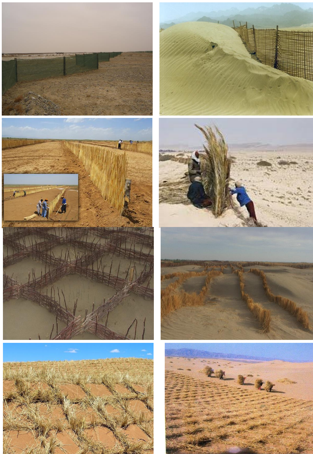
شکل ۱-۳۲- نمونه‌هایی از بادشکن مکانیکی بلند (۴ تصویر بالا) و کوتاه (۴ تصویر پایین)
