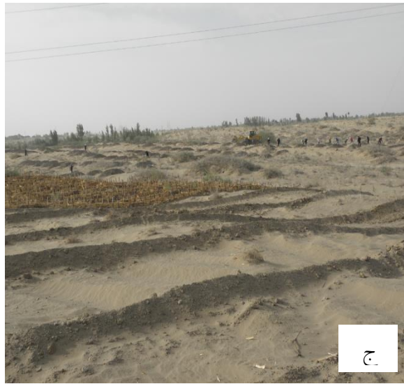
شکل ۱-۲۹- مواد مختلفی جهت ایجاد بادشکن مکانیکی (الف) شیمیایی، (ب) پلاستیکی، (ج) پشته رسی، (د) بقایای گیاهی، (ه) فنس فلزی و (ز) پیکه چوبی و (ر) گیاه مصنوعی (زارع، ۱۳۹۹)
