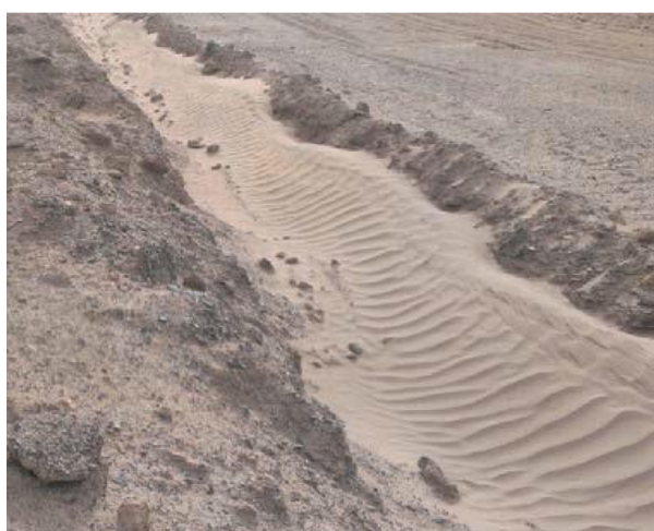
شکل ۳-۷- رسوب ماسه درون خندق‌ها
