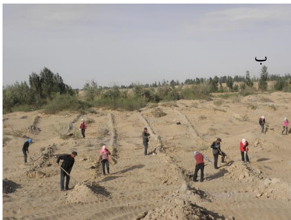
شکل ۱-۵۴- استفاده از ادوات مختلف جهت احداث پشته‌های رسی (الف) ماشین‌آلات و (ب) نیروی کارگری
