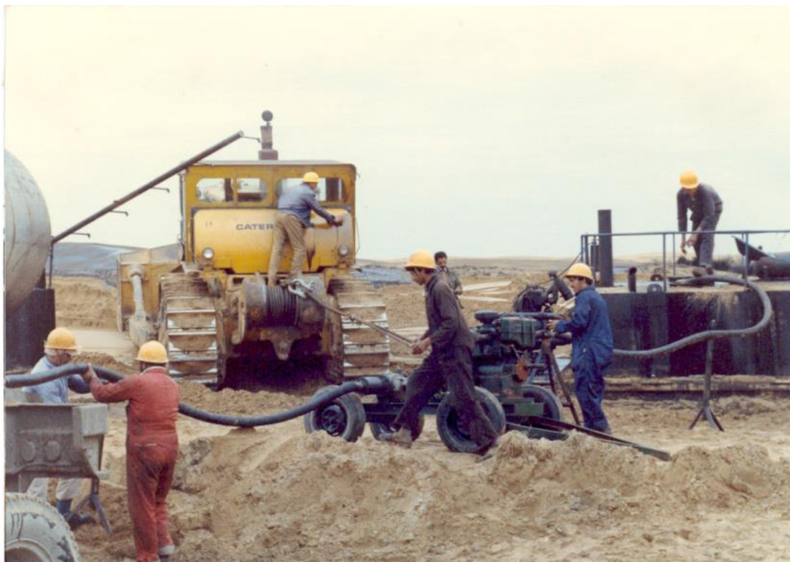
شکل ۲-۱۷- تخلیه مالچ از تانکر به اسکی از طریق پمپ
