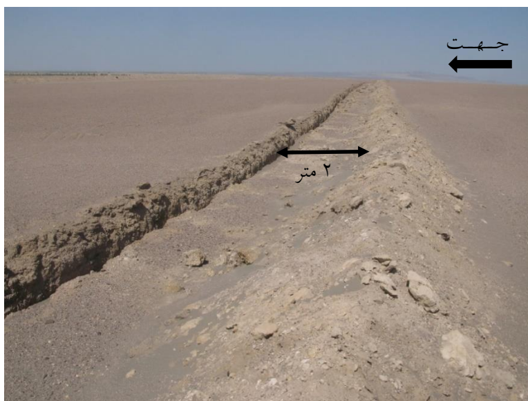
شکل ۳-۸- نمایشی از خاکریز ایجاد شده
