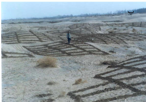
شکل ۱-۵۵- حالت‌های مختلف احداث پشته‌های رسی (الف) نواری و (ب) شطرنجی
